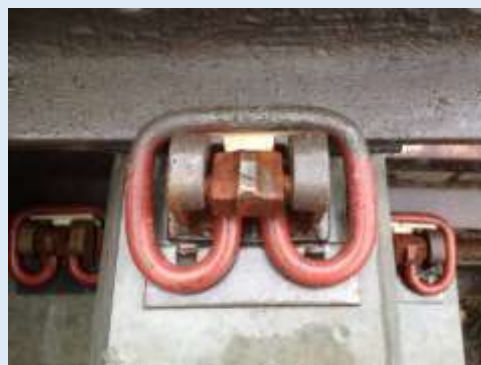
1-clemă, 2-fixator, 3-ancoră, 4-regulator, 5- colț de izolare, 6- căptușeala din cauciuc
