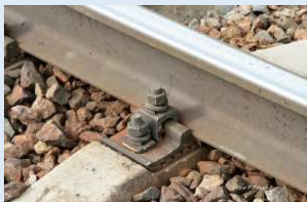
Fig. 2.27 – Prindere intermediară separată cu traversele din beton armat cu ajutorul buloanelor și clemelor
