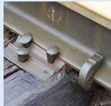
Fig. 2.26- Prindere intermediară separată, neseplată și mixtă
