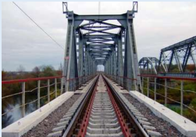
Fig. 2.37 – Construcția traseului pe pod
