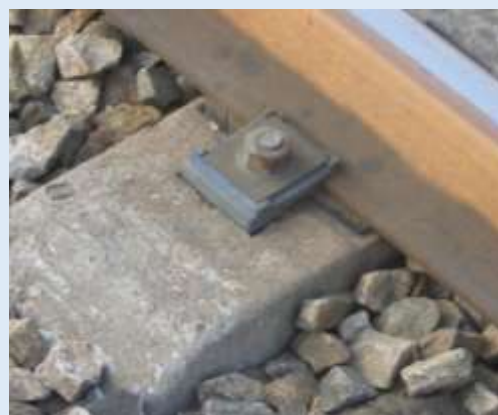
Fig. 2.28 - Prindere intermediară neseplată cu traversele din beton armat cu ajutorul șuruburilor și clemelor
