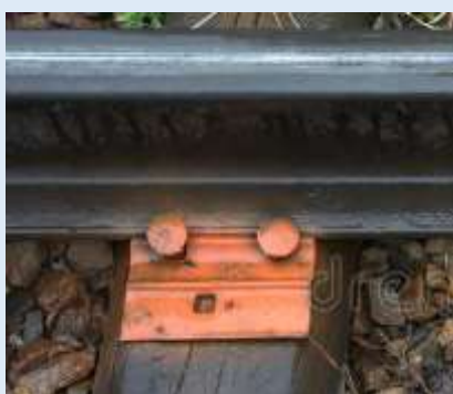
Fig. 2.26- Prindere intermediară separată, neseplată și mixtă
