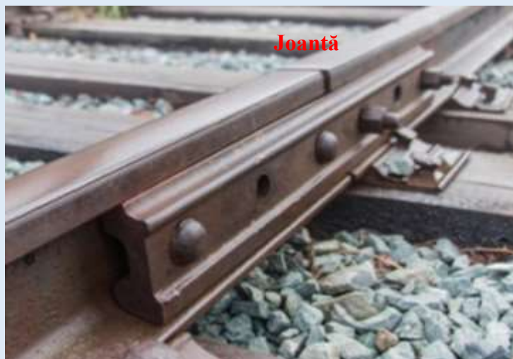
Fig. 2.32- Îmbinarea sinelor pe traseu
