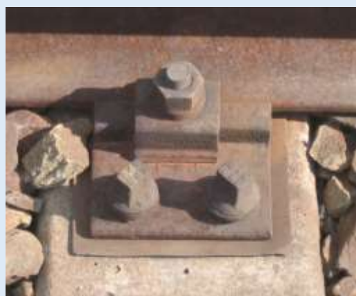
Fig. 2.29- Prindere intermediară separată cu traversele din beton armat cu ajutorul șuruburilor, clemelor și buloanelor
